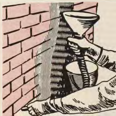
25. ábra VANDEX injektáló habarcs alkalmazása
