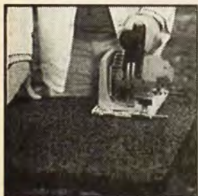
3 A parafalemezeket géppel vagy kézfűrésszel beszabjuk.
