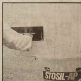
9 Záróbevonatként felhordjuk a vakolatot.
